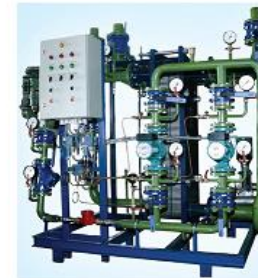
ІНДИВІДУАЛЬНИЙ ТЕПЛОВИЙ ПУНКТ
